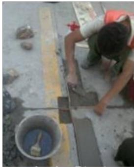
很多客户经常会问灌浆料能达到多少强度？普通的灌浆料28天强度也能达到C60这也是国家标准要求的，一些特殊的环境，比如风机基础灌浆要求达到C80核电设备灌浆要求达到C110而且还有一些早强型灌浆料，特点是早期强度发展特别快，比如支座砂浆、支座灌浆料要求2h强度达到C20级别，总之灌浆料的强度是普通水泥砂浆无法达到的，那么灌浆料的强度是如何实现的呢灌浆料的骨料采用硬度比较高的石英砂，而且石英砂分为多个级配，达到堆积密度，密度越大比重越大。其次灌浆料以水泥作为结合剂，水泥采用高标号水泥，一些特殊类型灌浆料则要搭配硫铝水泥、高铝水泥等，通过水泥的配合可以控制水泥水化的速度，在一定时间内达到要求的强度。另外高效塑化剂作为灌浆料添加剂之一，可以减少加水量、增加浆体拌合性，用较少的水就能使灌浆料达到拌合的状态，加水量越少浆体空隙越少，强度也就越高。当然还有一些矿物掺合料，主要为了达到浆体的密实性，总之几方面的因素共同提高了灌浆料的强度。
